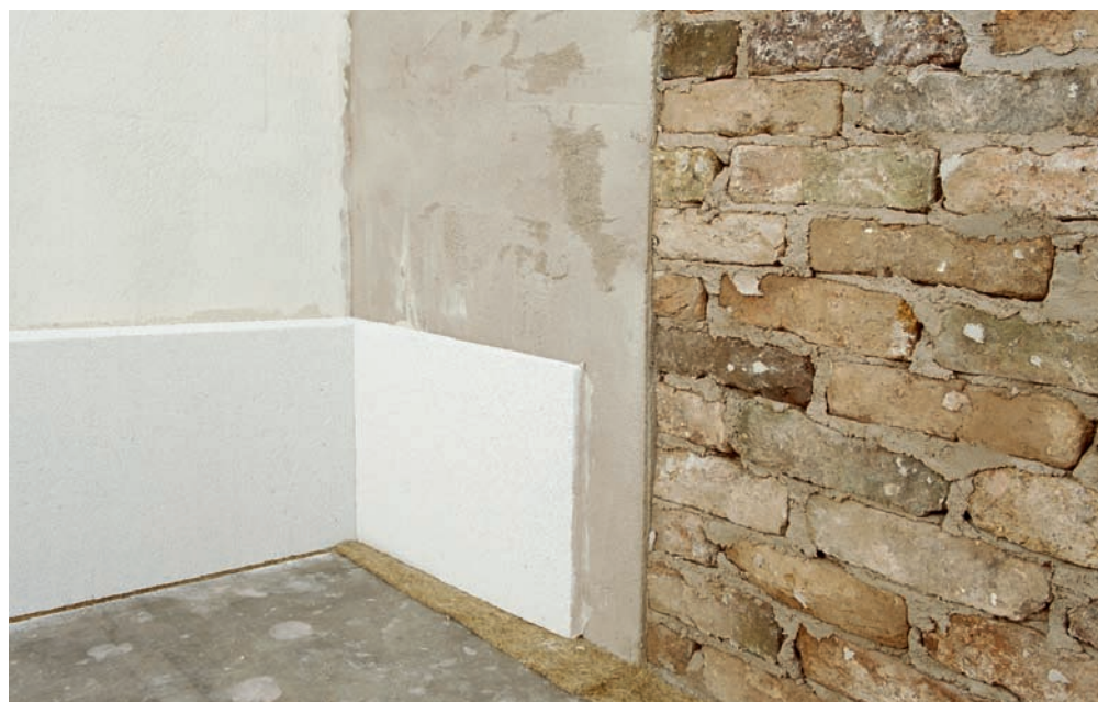
Untergrund vorbereiten, Schadstellen im Mauerwerk mit Füllmörtel schließen, Wandfläche ggfs. mit Ausgleichsputz planieren, Leichtmörtel auf Mineraldämmplatte auftragen, ansetzen, andrücken – fertig
