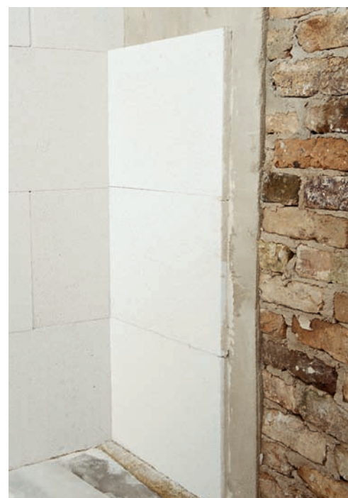
Untergrund vorbereiten, Schadstellen im Mauerwerk mit Füllmörtel schließen, Wandfläche ggfs. mit Ausgleichsputz planieren, Leichtmörtel auf Mineraldämmplatte auftragen, ansetzen, andrücken – fertig
